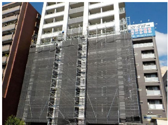
コンフォリア笹塚における大規模修繕工事
