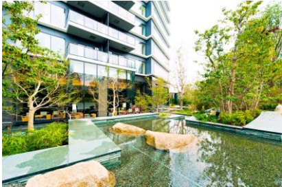
敷地面積1,000㎡以上であるため、「東京における自然の保護と回復に関する条例」に則って緑化計画を策定しており、緑豊かで自然あふれる空間を演出しています。
