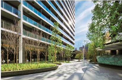
窓に省エネ型ガラスを採用しており、日射の量を抑え暑さを軽減し、空調負担の軽減に寄与しています。
