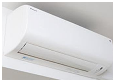
空調設備の更新
