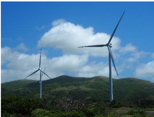
リエネ松前風力発電所 (北海道)
