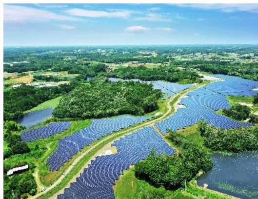
リエネ行方太陽光発電所 (茨城県)
